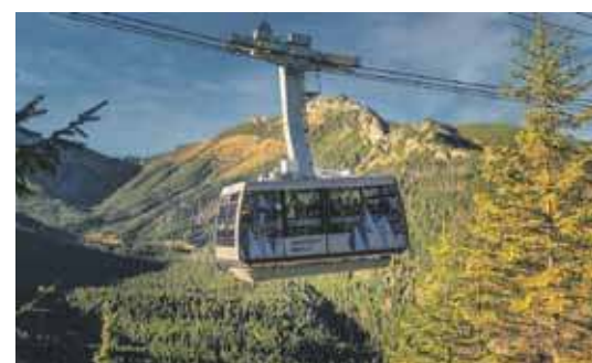
Kolej linowa na Kasprowy Wierch
