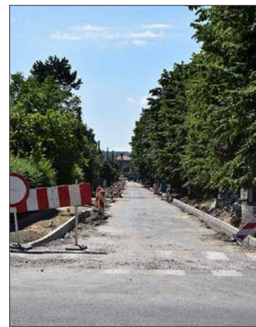
Przy ul. Grunwaldzkiej prace już trwają.
