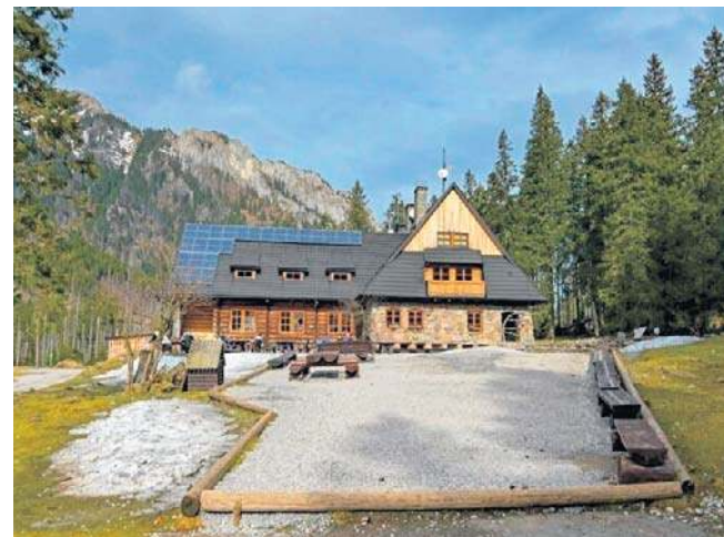
Prace remontowe w schronisku PTTK „Ornak” w Dolinie Kościeliskiej potrwać do 1 grudnia
