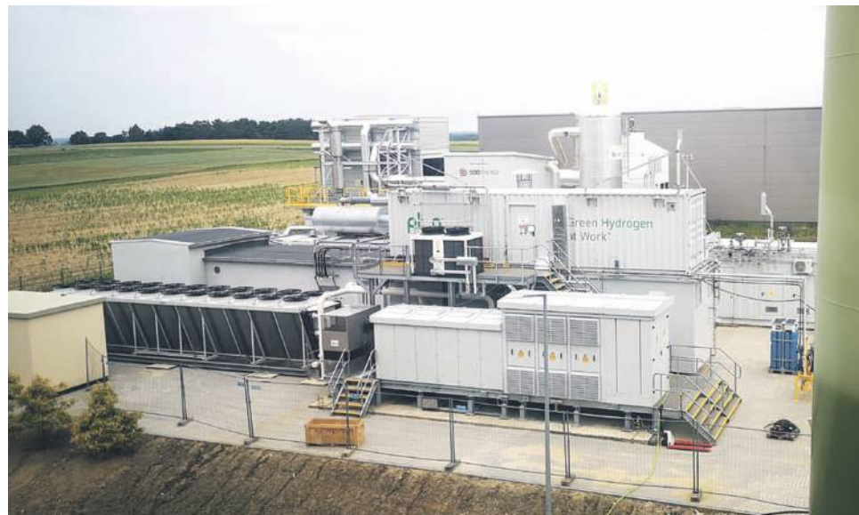
GAJ OŁAWSKI Tu powstaje wodór. Należący do firmy Promet Plast elektrolizer jest największym tego typu urządzeniem na świecie (moc 5 MW), produkującym w pełni zielony wodór, czyli z wykorzystaniem jedynie energii odnawialnej
