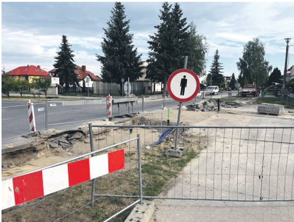
Na Osiedlu Metalowców trwają dwie inwestycje. Pierwsza to przebudowa skrzyżowania Tańskiego, Alei Młodych i Liliowej...
