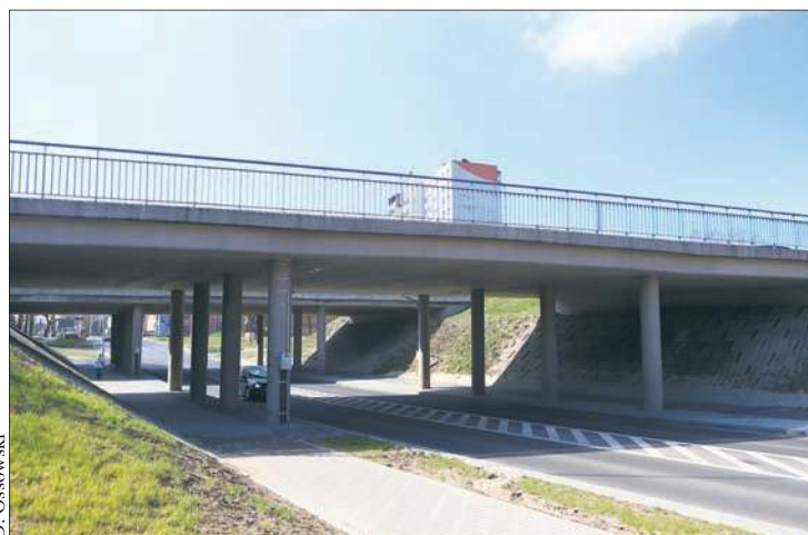
Po wykonaniu modernizacji
