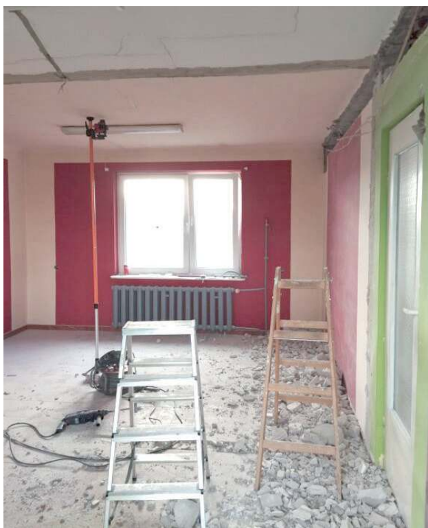
Świetlica środowiskowa w Księżpolu zamienia się w wielki plac budowy
