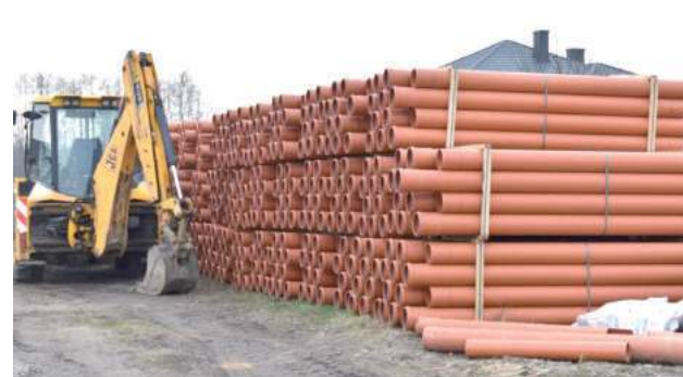
W Majdanie Nowym i Majdanie Starym trwa budowa kanalizacji sanitarnej
