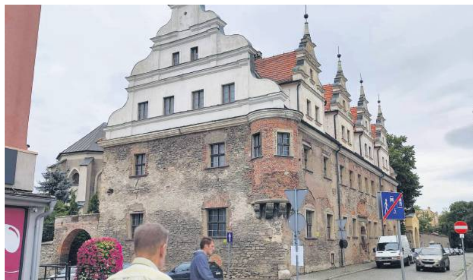
Niestety, po raz kolejny nie udało się pozyskać dofinansowania na remont Domu Książąt Brzeskich
