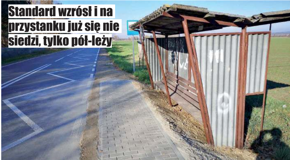
Remont drogi wyszedł pięknie, przystanek doczekał się nawet kostki brukowej...
