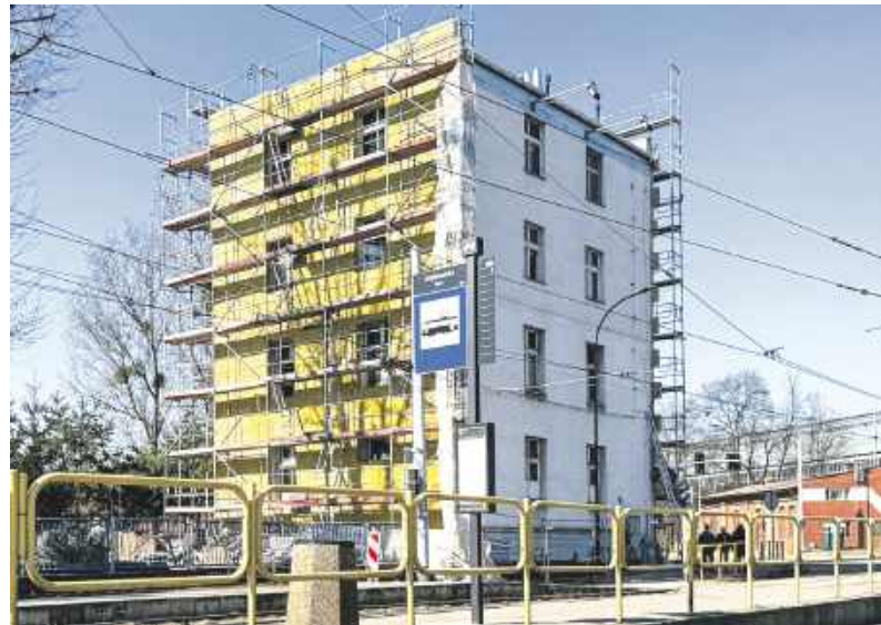
Po kapitalnym remoncie budynek znowu będzie przydatny
