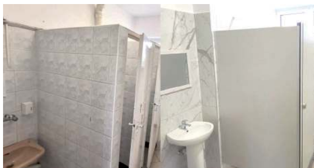
Pierwszy etap remontu sanitariatów zakończony. Już za chwilę rusza kolejny (zdjęcie przed i po remoncie)
