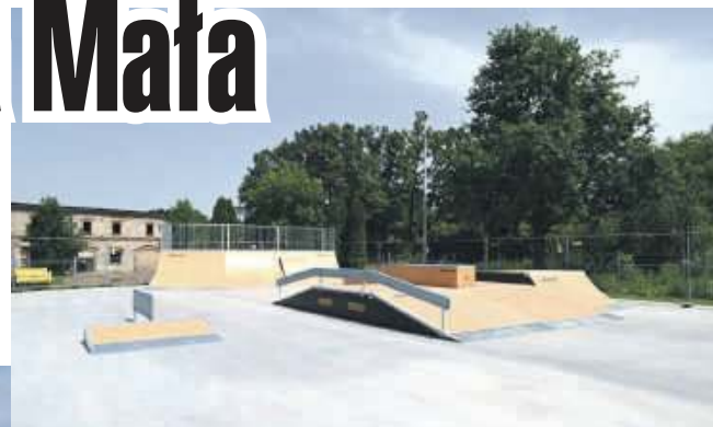
Na terenie budowanego skate parku w Strzeszowie zostały zamontowane wszystkie rampy
