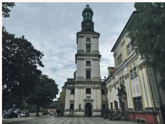
Prace konserwatorskie w Bazylice
