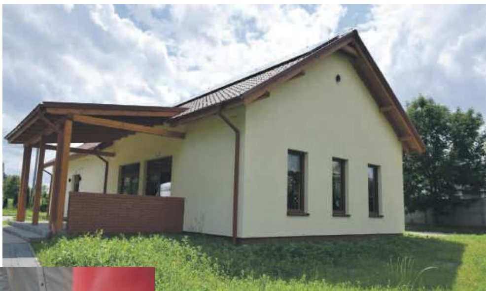
Świetlica wiejska w Tarnowcu
