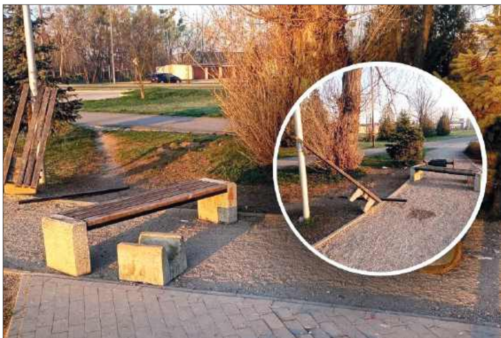
Zniszczona ławka na Błoniach MOSiR
