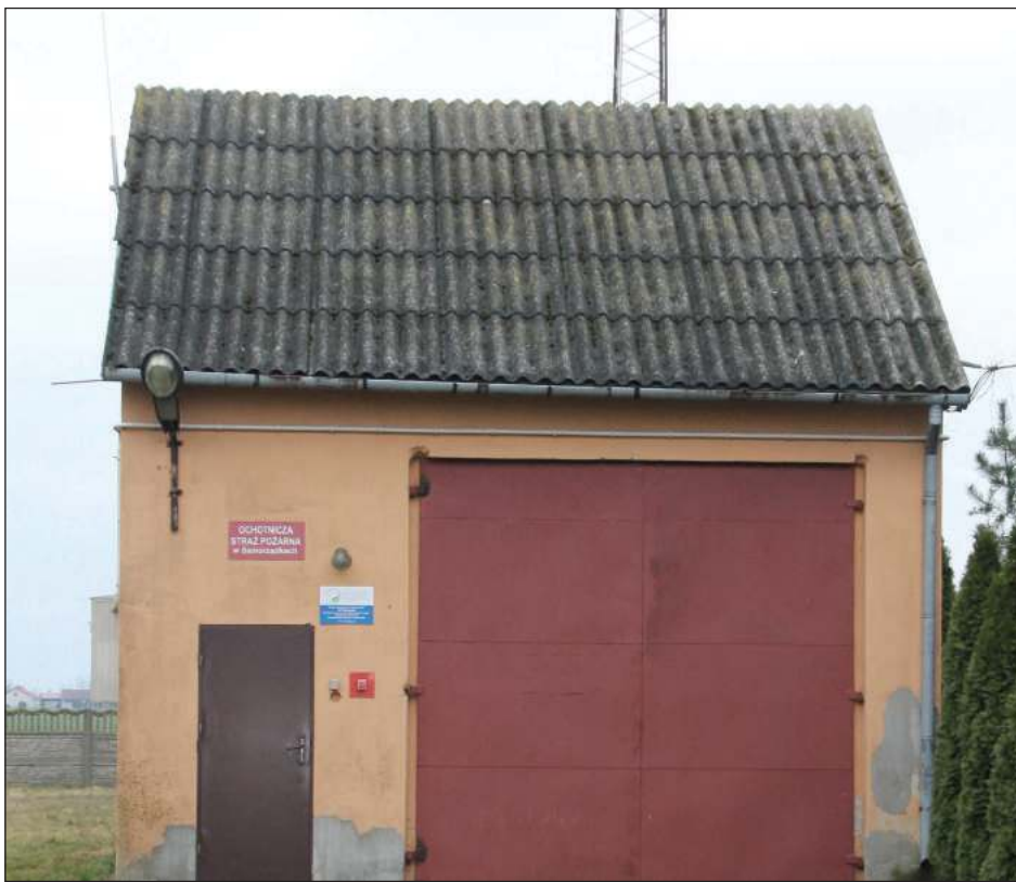
➦ Garaż strażnicy OSP w Samorządkach zostanie wyremontowany i dobudowane zostaną nowe pomieszczenia
