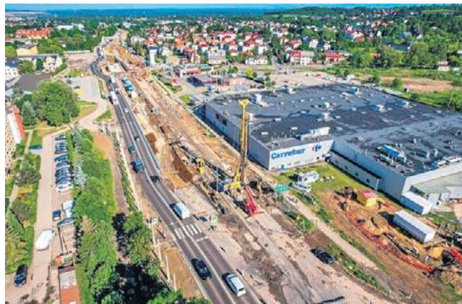
Harmonogram prac uległ zmianie, a podziemne pustki drastycznie opóźniają finał całej inwestycji w Olkuszu
