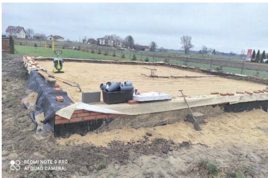
Świetlica w Olszance wyrasta już z ziemi
