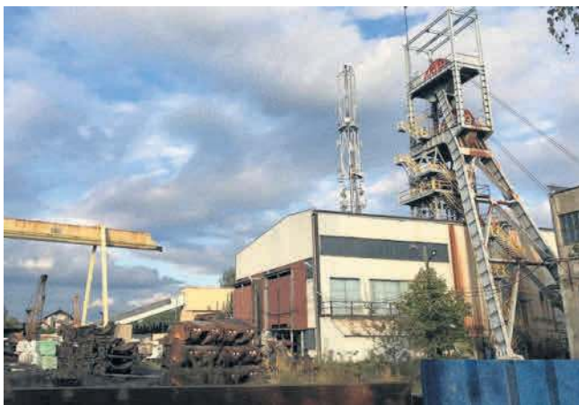
KWK Bielszowice, szyb Wygoda, gdzie doszło do tąpnięcia
