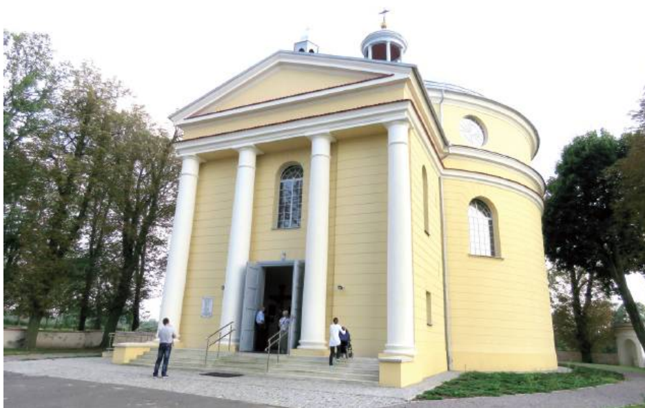
Kościół w Żyrzynie przejdzie remont. Zostanie wykonana m.in. wymiana elementów konstrukcyjnych więźby dachowej, wzmocnienie deskowania, wzmocnienie tynku czy odnowienie malowideł na suficie kościoła
