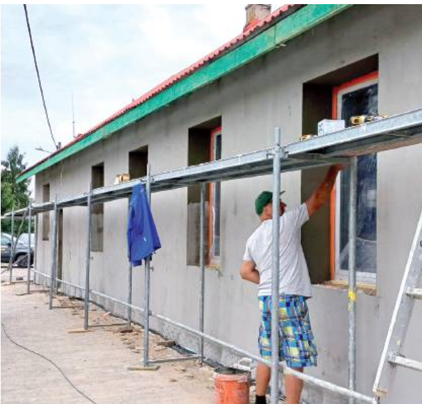
Prace nad budynkiem remizy strażackiej w Dąbrówce trwały 4 lata
