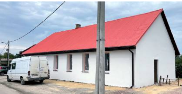
Tak się prezentuje obecnie strażnica po remoncie. Koszt samej termomodernizacji wyniósł 100 tys. zł
