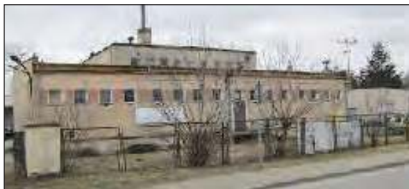
Widok nieruchomości budynkowej od strony ul. Grunwaldzkiej
