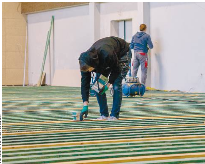
Tymczasem w hali widowiskowo-sportowej MOSiR-u postępuje remont sali do siatkówki i koszykówki.
