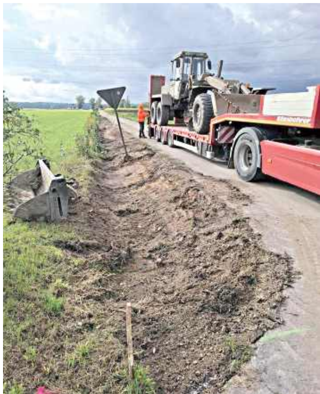
Na 800-metrowym odcinku dotychczasowa nawierzchnia tłuczniowa zostanie zastąpiona asfaltem
