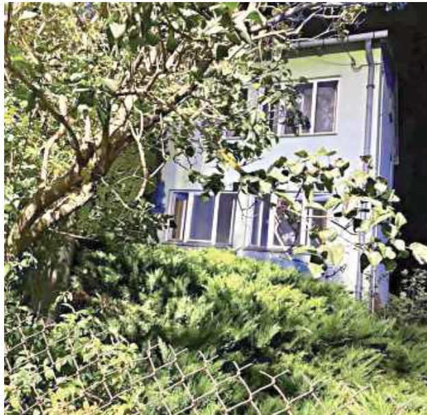
Po ugaszeniu ognia strażacy przystąpili do prac rozbiórkowych oraz przelewania pogorzeliska
