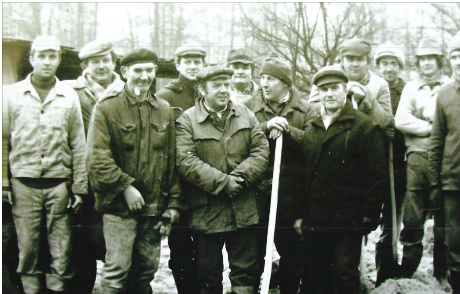
» Budowa Domu Strażaka w Woli Rębkowskiej. Rok 1990. Zdjęcie ze zbiorów Ochotniczej Straży Pożarnej w Woli Rębkowskiej
