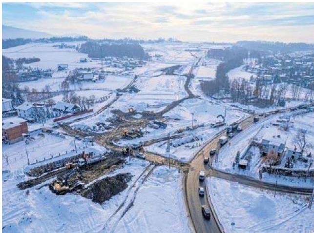
Mimo zimy, trwa budowa drogi ekspresowej S1 z Bielska-Białej do Oświęcimia i dalej do Mysłowic
