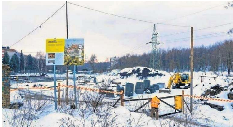
Wcześniej, odstąpiono od umowy z dotychczasowym wykonawcą, który nie wywiązał się z terminów realizacji robót budowlanych
