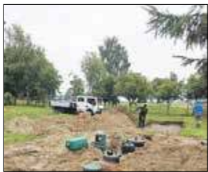
Mieszkańcy gminy już korzystają z własnych oczyszczalni ścieków
