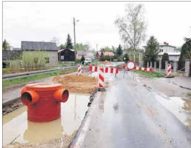
W wielu miejscach fundusz sołectki zdecydowano przeznaczyć na remonty dróg i budowę chodników
