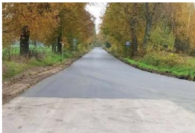
Fragment ukończonego odcinka Turów - Worsy
