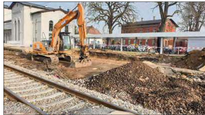
Tu będzie przejście pod torami.
