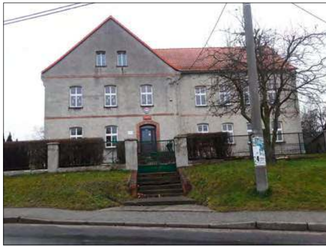
Mieszkańcy Krępnej obawiają się, że budynek popadnie w ruinę.
