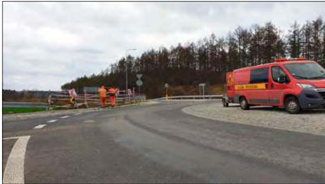
Już 31 grudnia 2019 r. po naszym artykule drogowcy prowizorycznie zabezpieczyli barierki.
