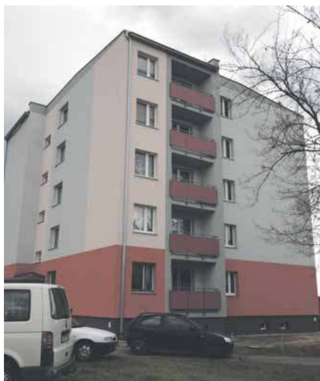
Termomodernizacja ma wpływ nie tylko na estetykę i oszczędność ciepła, ale także likwidację niskiej emisji
