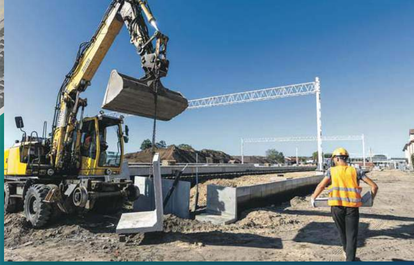
Montaż ścian peronowych
