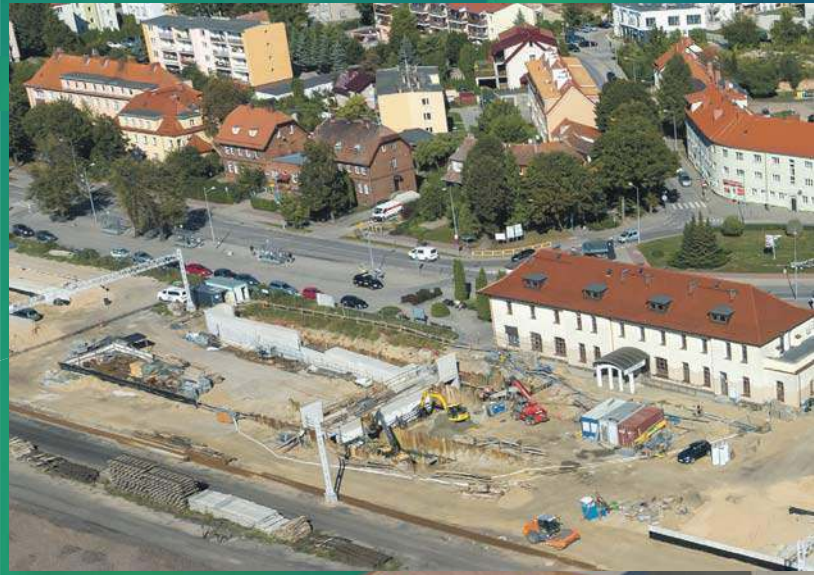
Przebudowa stacji Giżycko
