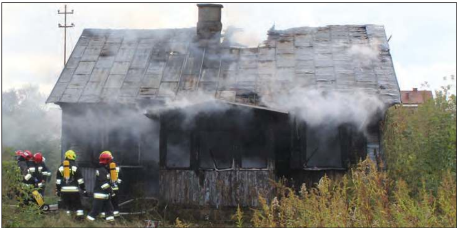
26-latek chwycił za kanister, rozlał benzynę po podłodze, a następnie ją podpalił i wyszedł. Pożar był gwałtowny. Ogień rozprzestrzenił się błyskawicznie. W mgnieniu oka płomienie odcięły możliwość opuszczenia domu przez drzwi wejściowe
