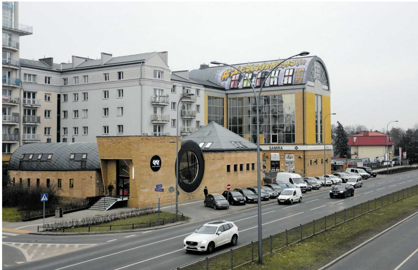
• Budynek przy ul. Powiśkiej 64A w Warszawie FOT. ADAM STĘPIEN / AGENCJA WYBORCZA.PL
