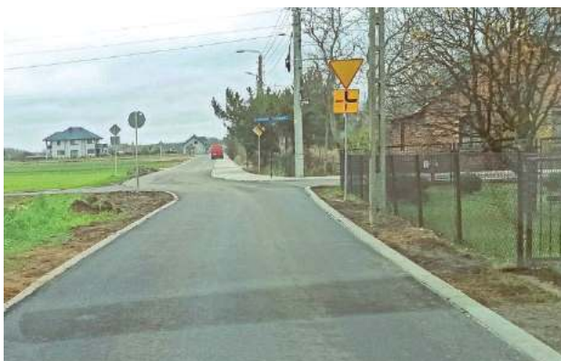
Ulica Poprzeczna po przebudowie
