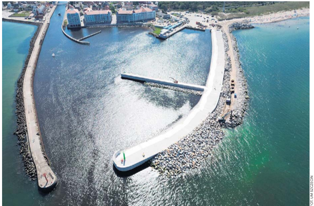
Inwestycja polegała na generalnej przebudowie falochronu w porcie Darłowo
