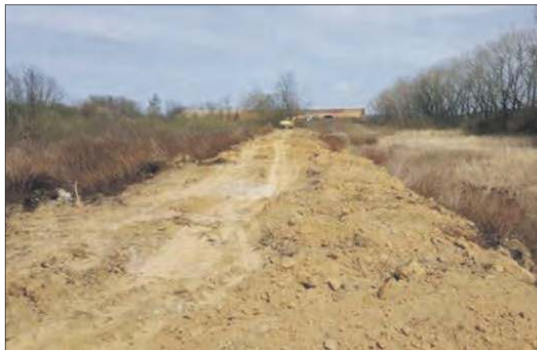
Teren inwestycji w trakcie makroniwelacji
