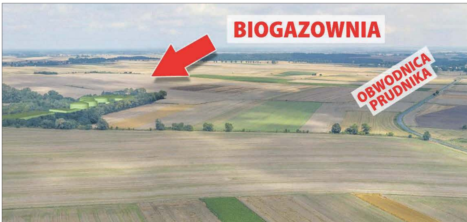
Biogazownia znajdować się będzie na terenie byłej strzelnicy między Prężynką a Prudnikiem
