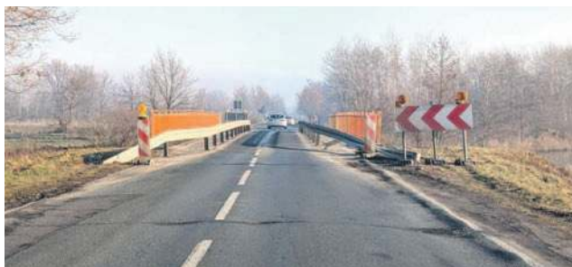
Wkrótce pojawią się to drogowcy w pomarańczowych kamizelkach i ruszy remont
