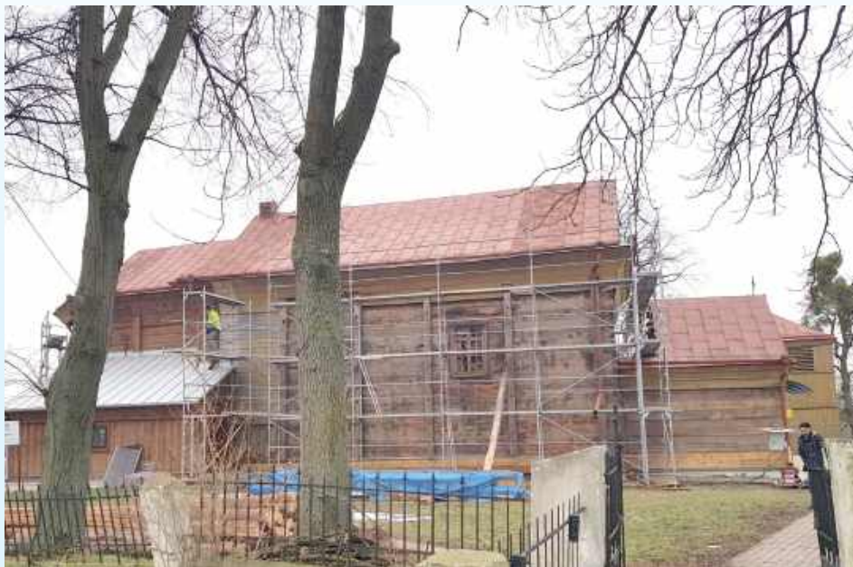
Szacunkowa wartość pilnego remontu kościoła w Dubie to ponad 6,3 mln złotych
