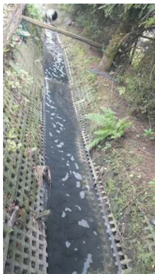
Pstrużnikiem wciąż płynie brudna i spieniona woda
