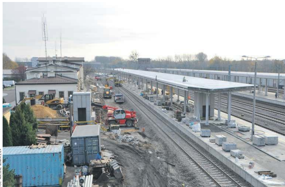
Modernizowana stacja kolejowa w Trzebinii
