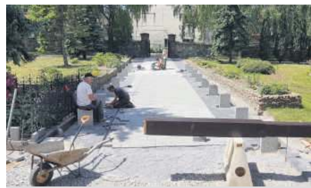
Zamiast betonowych płyt ułożona została kostka
