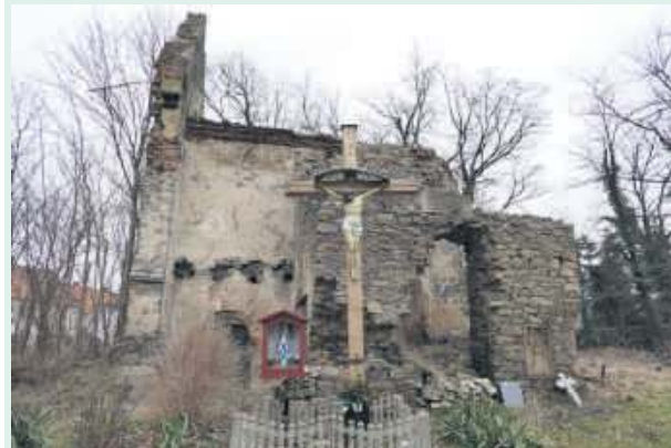
Projekt zabezpieczenia ruin kościoła w Miechowicach Oławskich kosztował 2 000 zł
