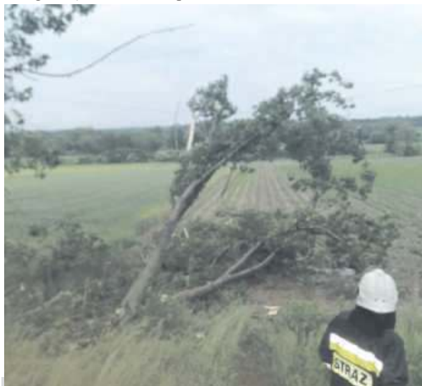
W Krzywiniu konar drzewa zawisł na linii energetycznej. Foto: OSP Przeworno
