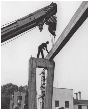
Budowa kładki nad torami
