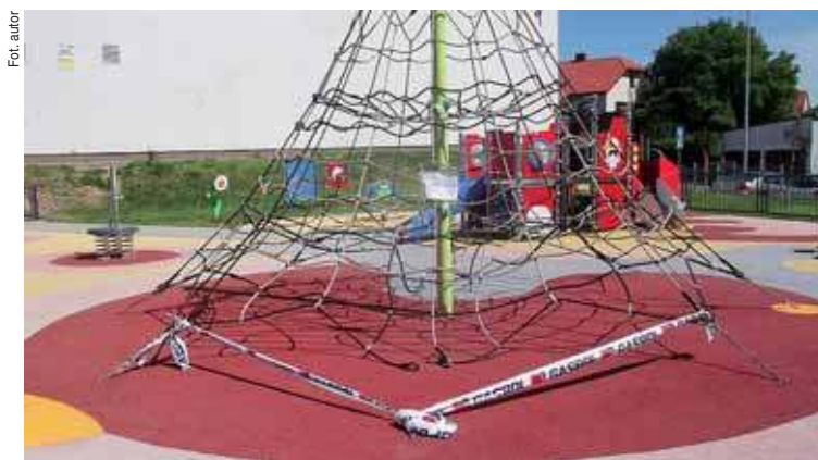
Uszkodzone linarium, dotąd cieszące się dużym powodzeniem, zostało wyłączone z użytkowania
