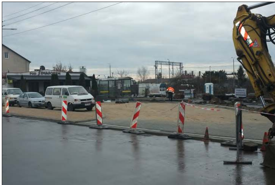
Prace przy modernizacji przystanku dobiegły końca. Efekt budzi zadowolenie władz miasta i mieszkańców.
