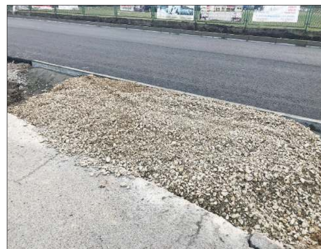
To tymczasowy dojazd wykonany w ciągu remontowanej drogi
