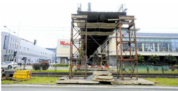
• Rozbiórka kładki pieszej przy Galerii Mokotów
