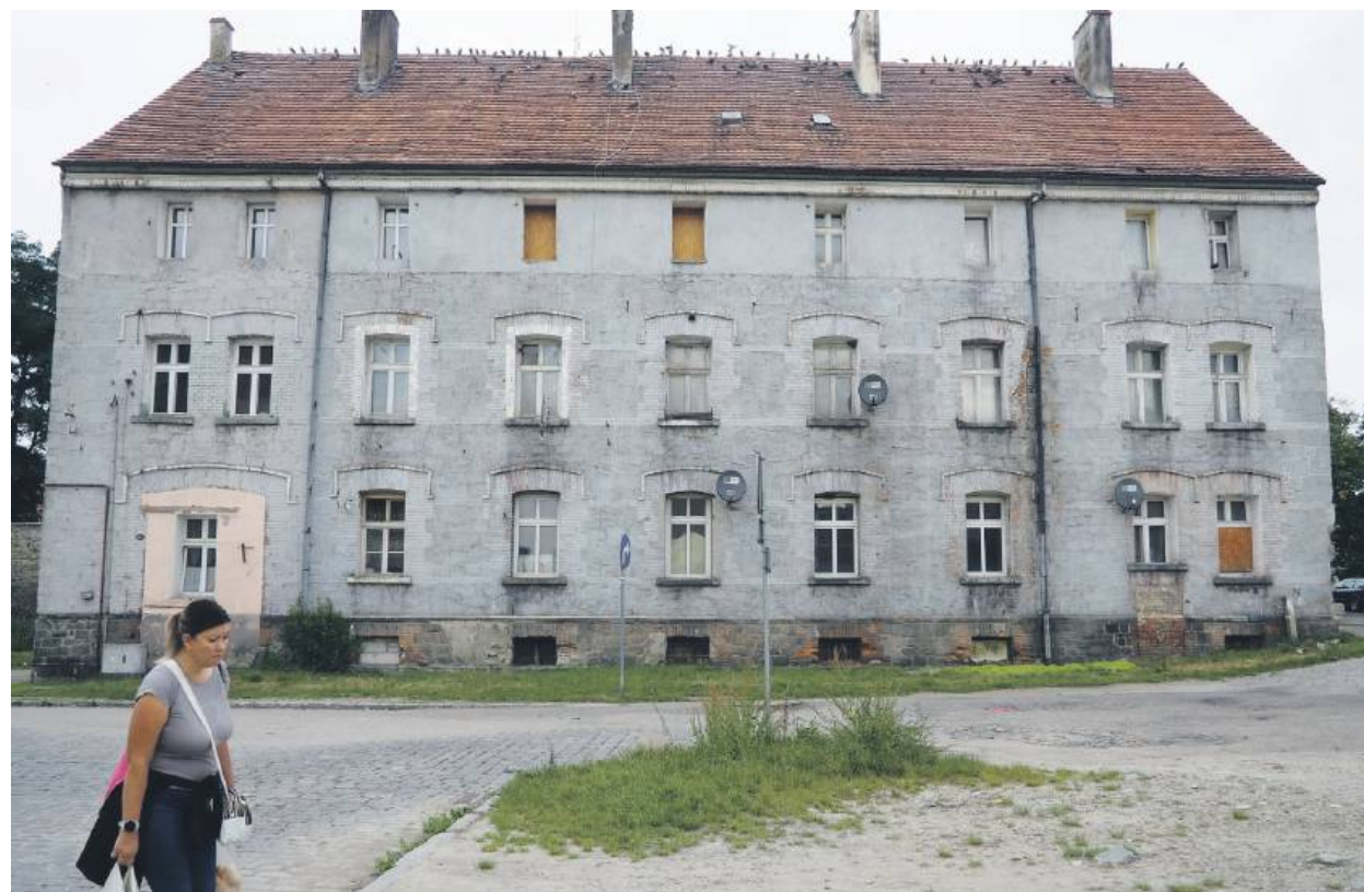
Nie ma konkretnych informacji, co dalej z budynkiem przy ulicy Pocztowej 4 w Strzelinie
