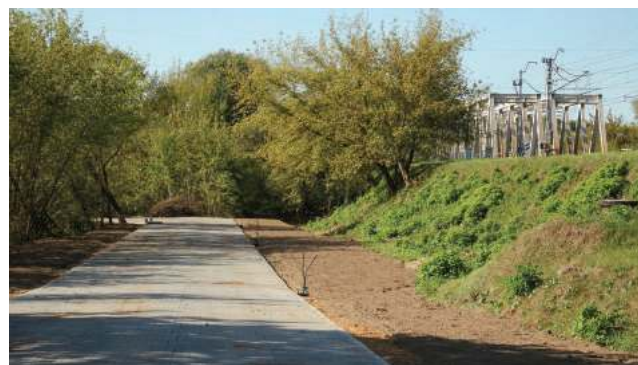
Praktycznie gotowa jest już droga dojazdowa
