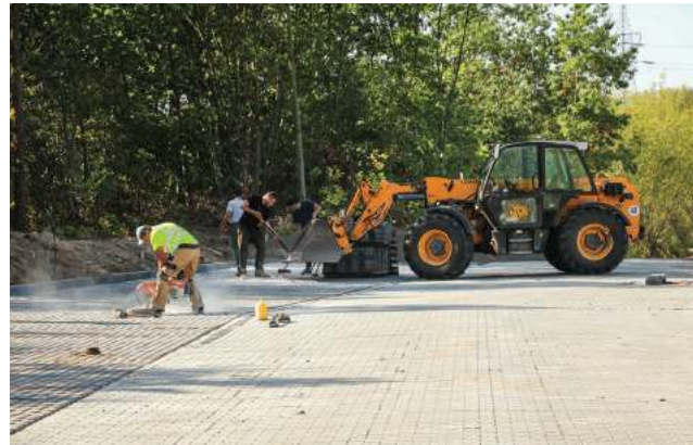
Prace przy budowie parkingu już trwają
