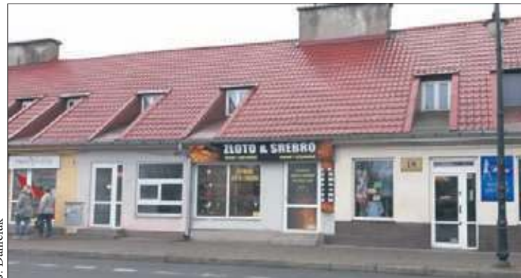
Kamienica przy ul. Królewieckiej 18
