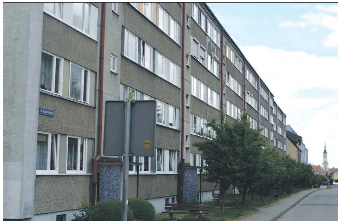
Na termomodernizację wciąż czekają mieszkańcy środkowego bloku przy ulicy Kombatantów. Dwa pozostałe już wypiękniały.
