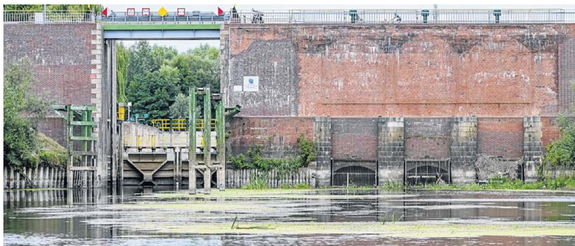
Stopień wodny w Białej Górze to śluza z wrotami przeciwpowodziowymi i jaz z przepławką dla ryb
