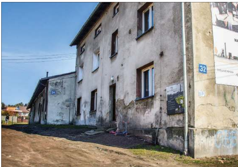
W trakcie remontu budynku przy ul. Hallera 32 i 34 w Radlinie tamtejsi mieszkańcy zostaną przeniesieni do kontenerów mieszkalnych.
