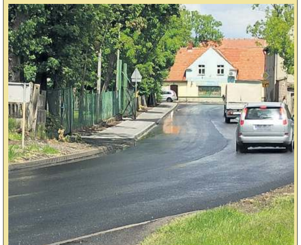
Przebudowa odcinka drogi w Chociwelu zmierza ku końcowi
