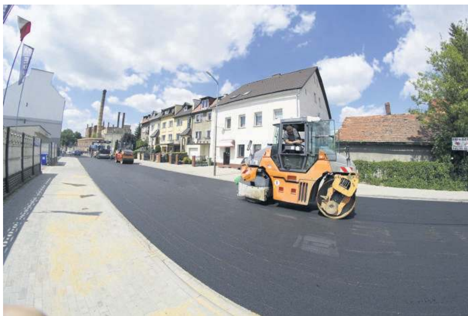
Remont ulicy Brzegowej obejmuje odcinek o długości prawie jednego kilometra. Prace powoli dobiegają końca
