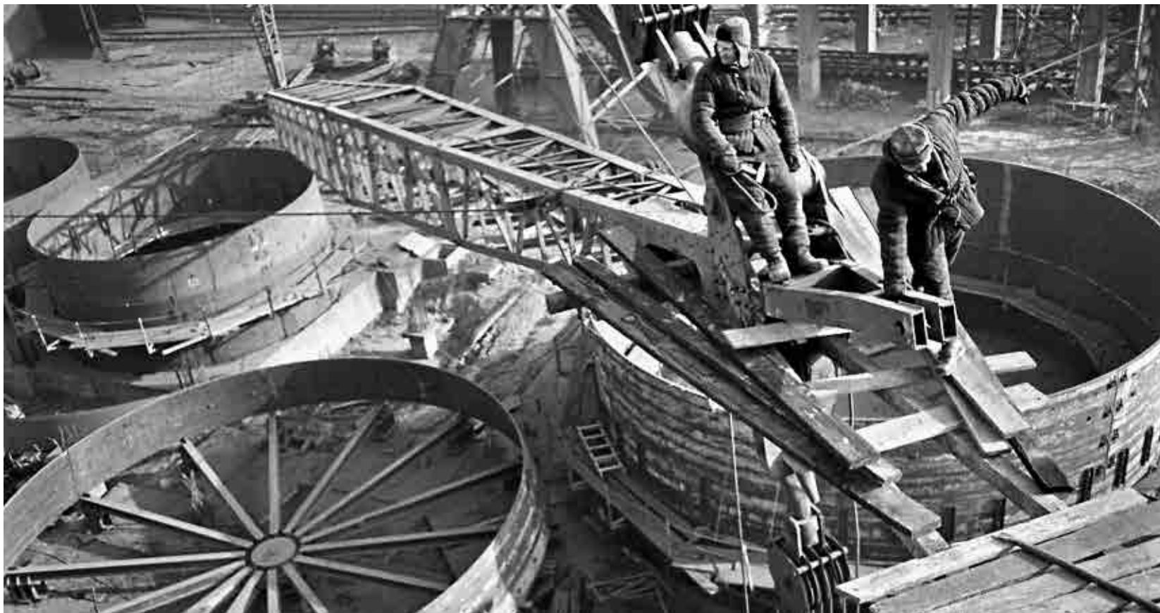
Kombinat metalurgiczny im. Lenina, rejon wielkich pieców, montaż korpusu na Wielkim Piecu nr 3 lub nr 4 – koniec lat pięćdziesiątych lub początek lat sześćdziesiątych
