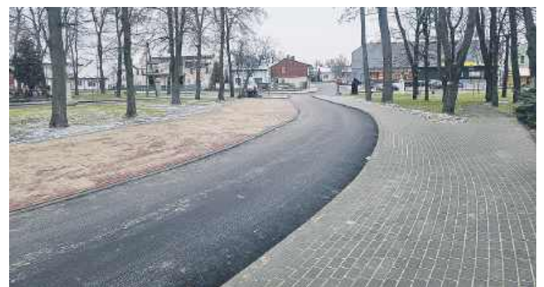
Wyremontowana ulica Kościelna w Siedliszczu
