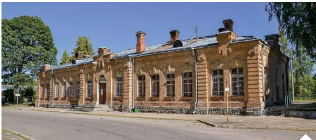
Dworzec kolejowy w Augustowie – dzięki Programowi Inwestycji Dworcowych – odzyska historyczne piękno, a jednocześnie spełniać będzie wymogi nowoczesnej użyteczności | fot. Wikipedia/d
